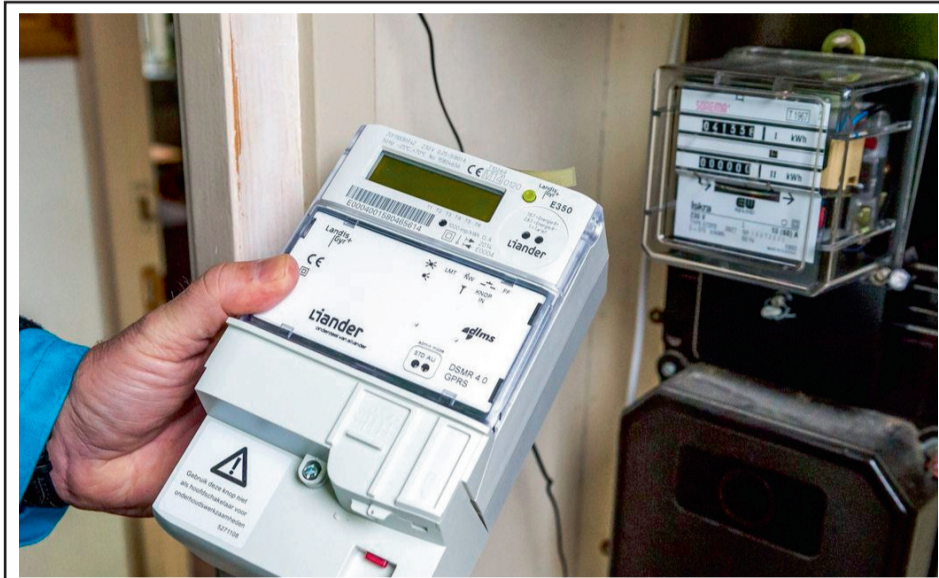
■ Een zogenaamde slimme meter is een digitale meter die zowel voor gas als elektriciteit kan worden geïnstalleerd. Hij wordt aangesloten op het internet en geeft zelf automatisch de meterstanden door.
